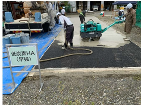
ホソーエース eco の施工状況
