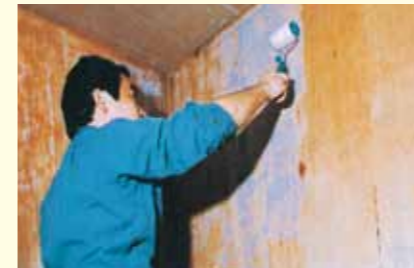
(1) プライマーの塗布
