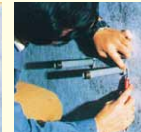
(5) 水道管廻りの処理
