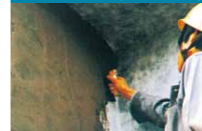
タイル湿式工法(ノンラス工法)
