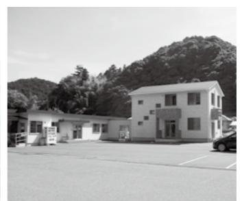
右側の建物が新築した事務所棟。2階の広い会議室では業務での使用の他、地域住民を招いたり産業観光ツアーでのプレゼン時の使用も予定
